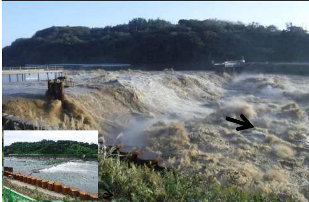
平常時 令和元年東日本台風時の 大河津分水路
