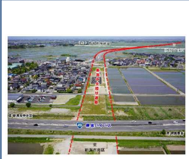
国道49号横雲バイパスと整備が進む新潟中央環状道路との交差点状況
