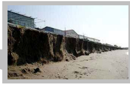
関屋浜海水浴場の侵食状況（平成18年9月）
