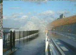
市道への越波状況
