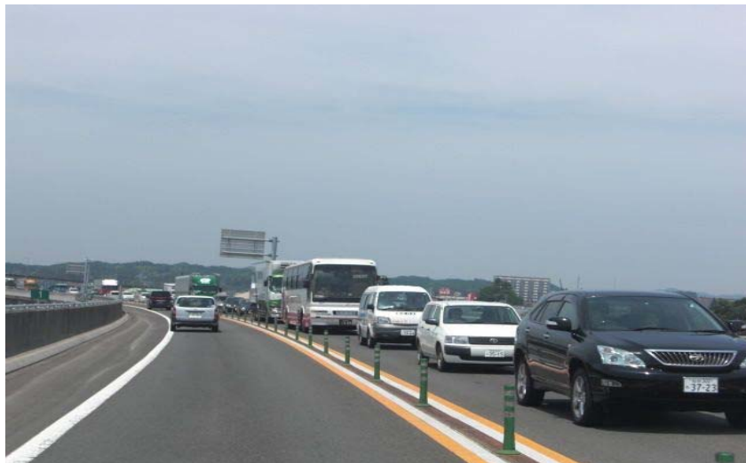
磐越自動車道 【暫定2車線の状況】 (新潟県 阿賀町付近)
