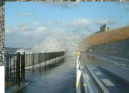
市道への越波状況
