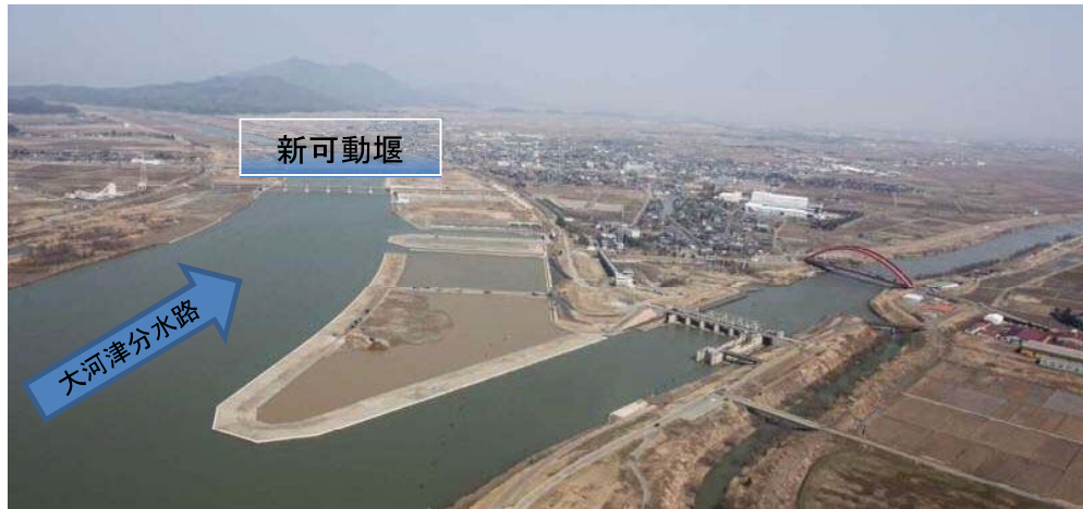
平成23年11月に新可動堰への通水が行われ、流下能力の向上が図られた。
