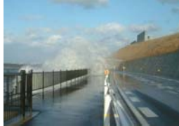
市道への越波状況
