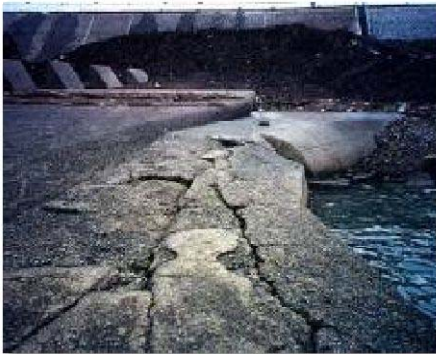
第二床固 水叩き部のひび割れ状況
