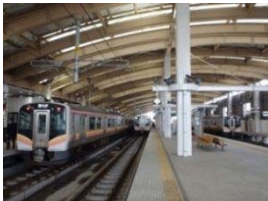
高架駅の様子
