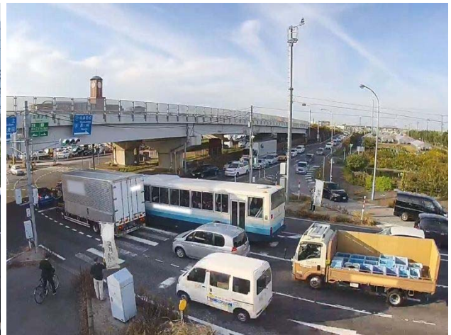
④ 国道7号竹尾IC事故対策 下りオフランプ混雑状況
