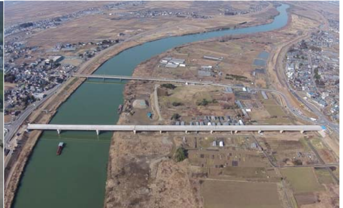
【整備中の臼井橋】
