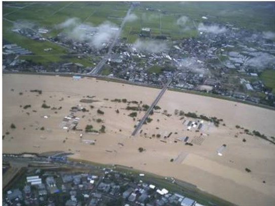
【冠水した臼井橋】
