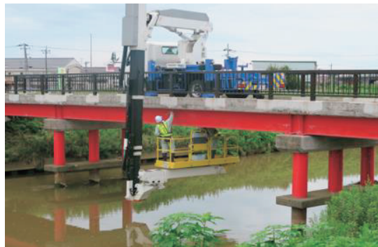
橋りょうの点検
