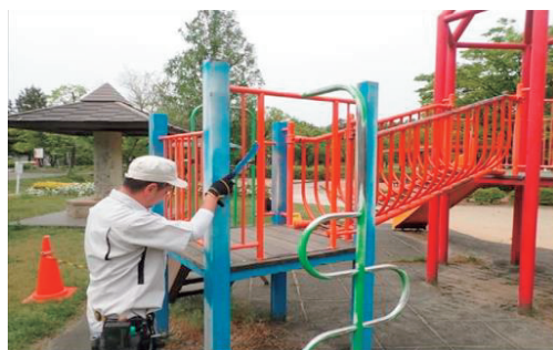
公園遊具の点検
