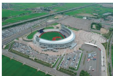
新潟県立野球場（総合スポーツゾーン）
