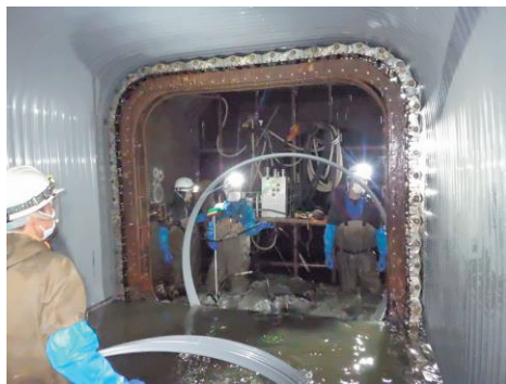
下水道管渠の改築工事
