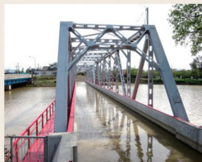
新川の上を通る西川水路橋
