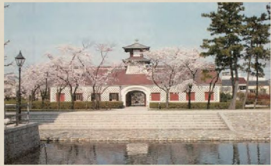
美しい春の旧新潟税関庁舎（正面）を復元された信濃川側荷揚げ場越しに望む
