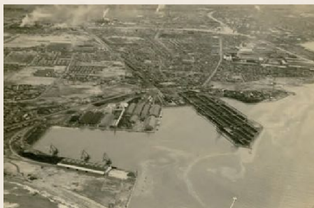
建設中の臨港埠頭 (大正時代後期)
