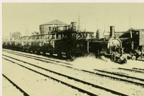
新津駅前の原油貯蔵タンクと原油輸送車 (新津鉄道資料館蔵)
