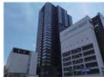
新潟駅南口第二地区
