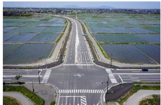
新潟中央環状道路 横越バイパス
