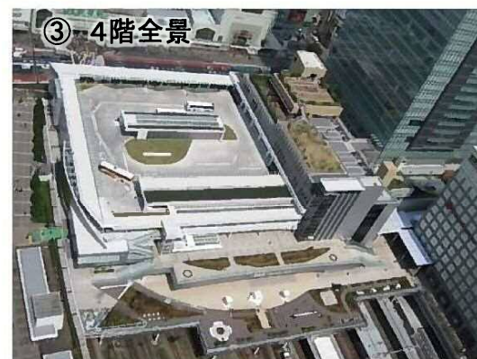
4階全景（高速バス関連施設）
