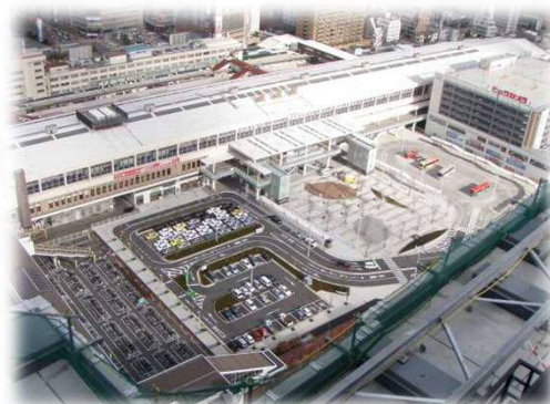
新潟駅南口広場 (H21第1期工事終了)
