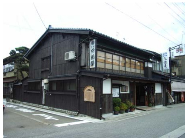
↑ 町屋の改修事例（村上）
