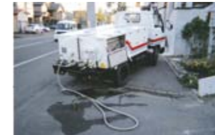
採水車で管内の滞留水を除去 (新潟県中越地震)
