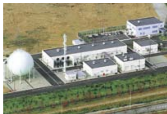
東港工場(製造設備)
