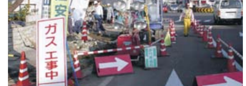
漏れ箇所を修理 (新潟県中越地震)
