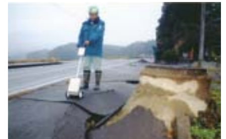
ガス漏れ箇所の調査 (新潟県中越地震)
