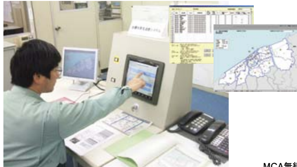
親局操作パネル(新潟支社指令室)
