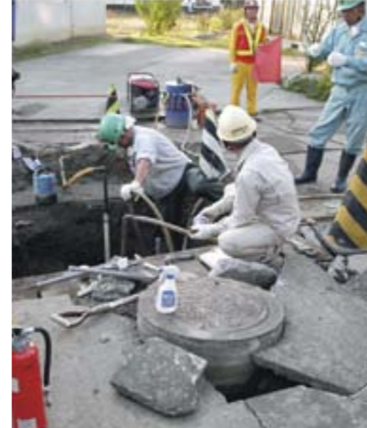
漏れ箇所を修理 (新潟県中越地震)
