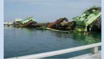
津波で倒壊した揚炭機
