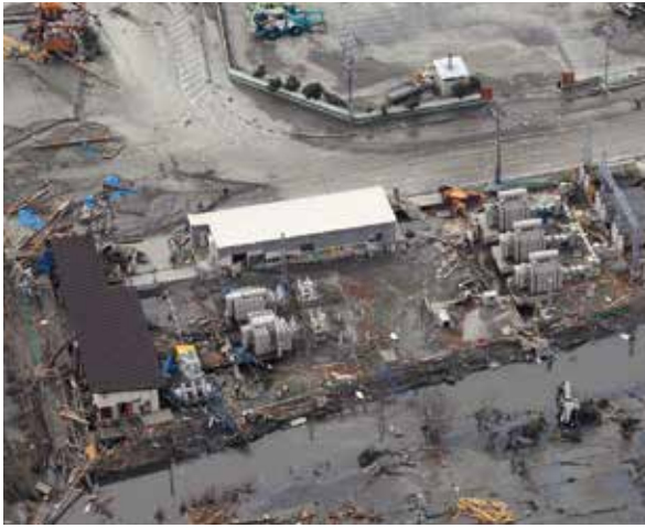
津波により壊滅的な被害を受けた重吉変電所(宮城県石巻市)
