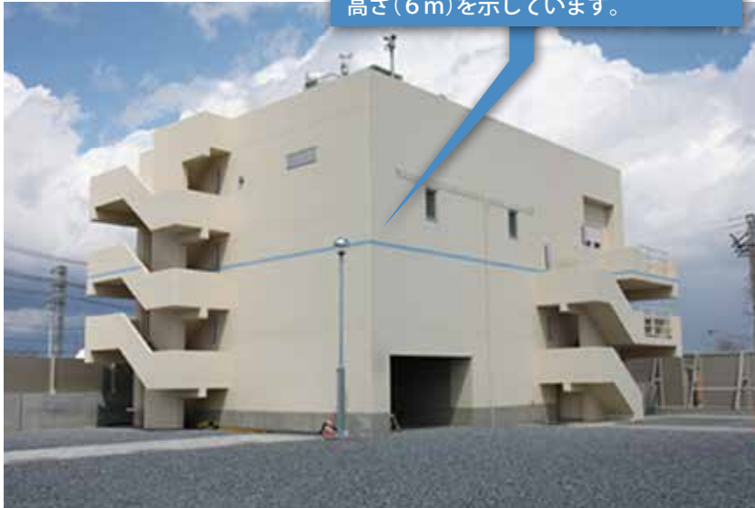
津波を受け流す「中空形式」を採用した建屋
