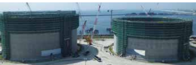
直径約80m、高さ約54mにおよぶLNGタンク
