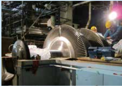
1号機ボイラ給水ポンプ組み立て
