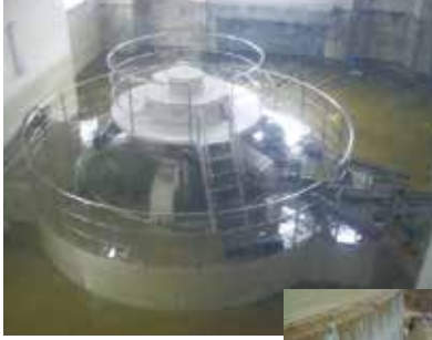
河川の氾濫により浸水被害を受けた伊南川発電所
