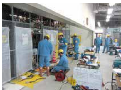
技能大会 変電部門（6kV 真空遮断器受入試験他）
