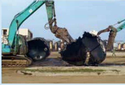
薬品タンク撤去
