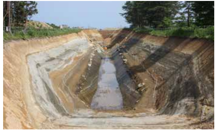
地形の高まりと断層の関連性などについて確認するためトレンチ調査を実施
