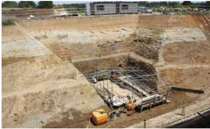
断層破碎部の詳細構造確認のため、側面から水平にボーリング調査を実施
