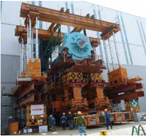
八戸火力発電所5号機発電機設置工事
