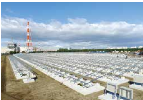
環境に配慮した資材の導入例 (アレイ架台に少ないめっき量で耐久性のあるプレめっき鋼板を採用)
