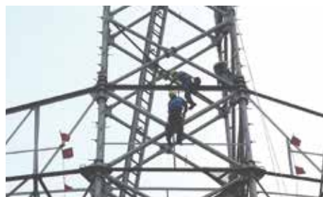
技能大会 送電部門（鉄塔の部材取替）
