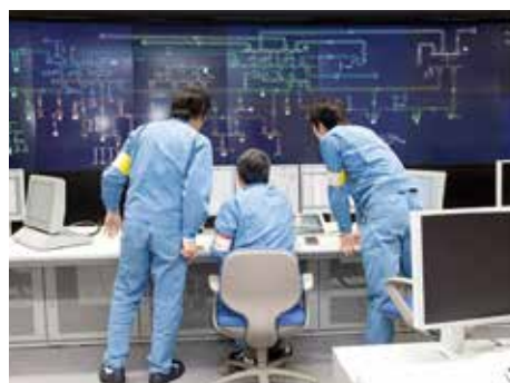
技能大会 給電部門（系統事故復旧操作）
