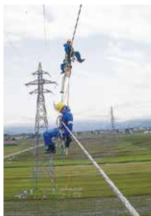
電線点検作業
