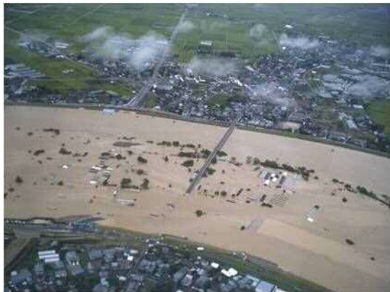
【冠水した旧臼井橋】
