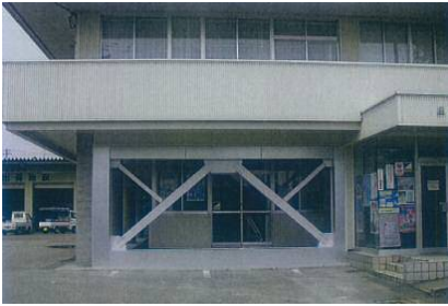
【庄瀬地域生活センター・補強工事の例】
