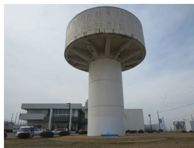
【阿賀野川浄水場 洗浄水槽】
