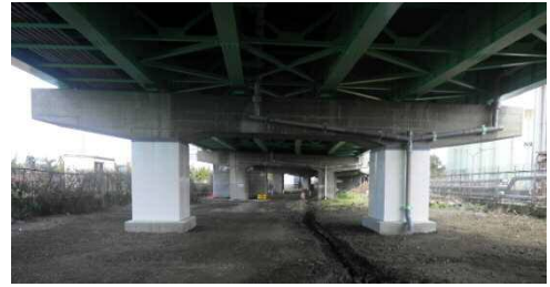
耐震対策工事の例】
