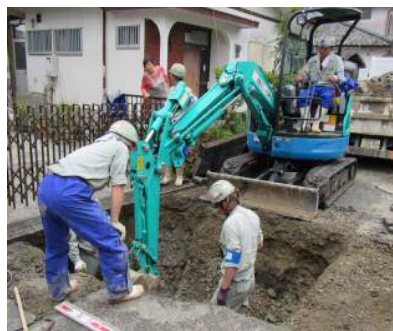
【上水道漏水調査・復旧支援】
