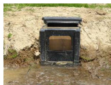
【排水調整装置：田んぼダム柵の例】
