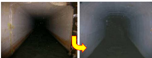
【鳥屋野幹線耐震化工事(プラスチック材による管渠内面被覆)】
