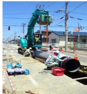
水道管工事の様子
