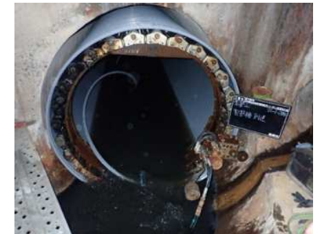
耐震化工事をした管路
