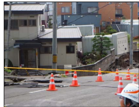
札幌市内の被害状況
