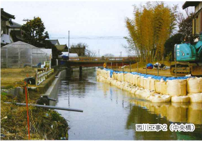
西川工事 (金巻橋)
