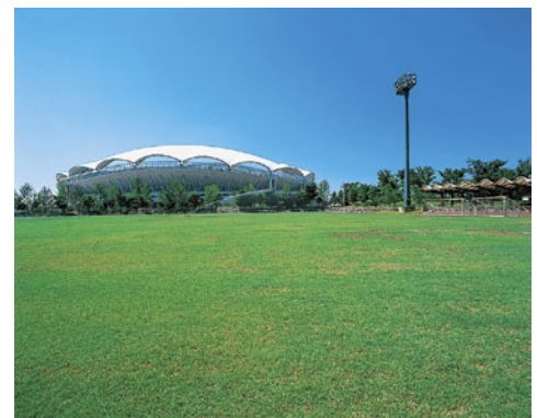
広域防災拠点にもなる鳥屋野潟公園
