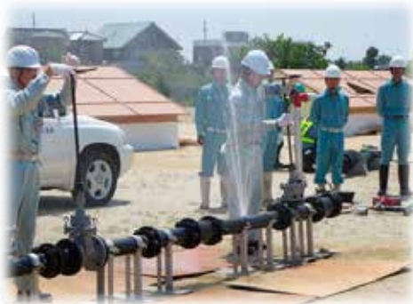
応急復旧訓練
