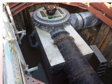
構内水管耐震化工事 (不断水切換弁)
