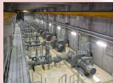
ポンプ設備更新工事
