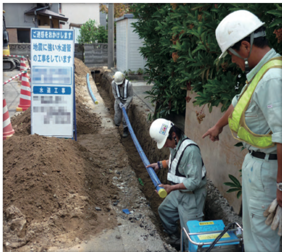
地面を掘って、水道管を入れかえています。
