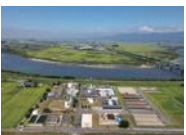
D 満願寺浄水場
