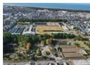
A 青山浄水場
