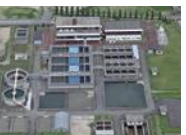
G 東港浄水場
