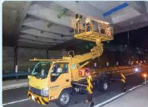
高所作業車による点検
