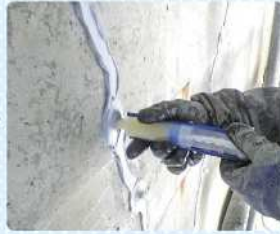
ひび割れの補修
