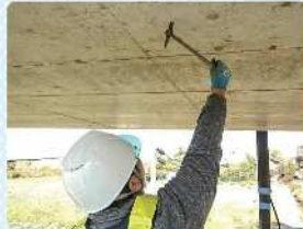
ハンマーを用いた状態確認
