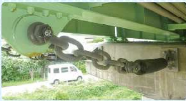
チェーンで桁と橋脚を結合する
