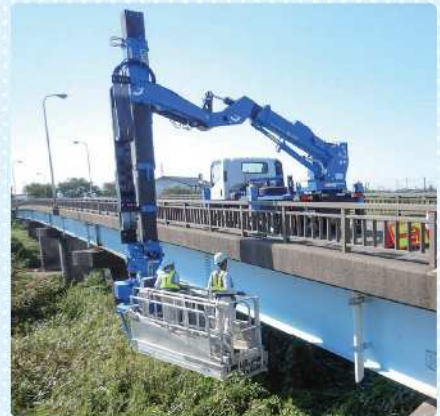
橋梁点検車による点検
