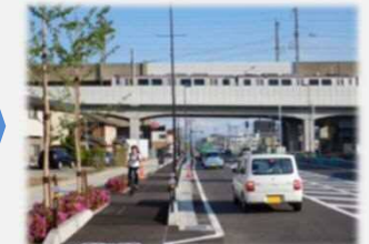
写真：新潟鳥屋野線 (2019年5月 一部開通)
