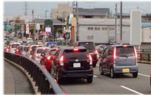
写真①：西跨線橋
