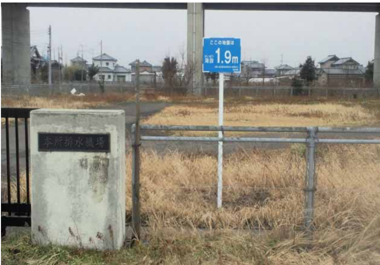
【本所排水機場】
