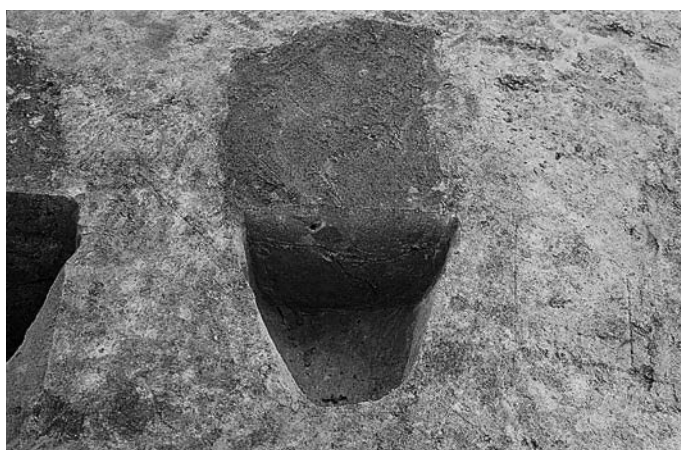
SD28 土層断面(北東→南西)
