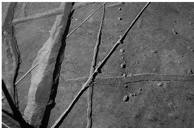
SD664 (SD2350 との交差部分) 完掘状況(南→北)
