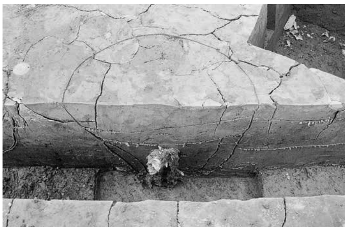
P194 (SB901) 断面 (西から)
