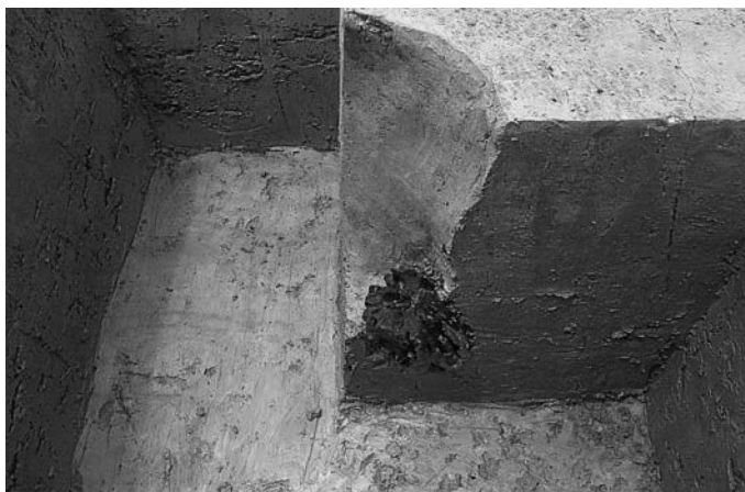
P346 (SB906) 完掘 (東から)
