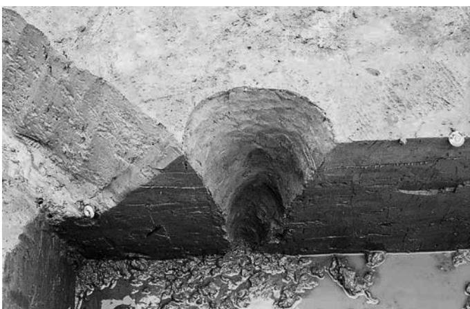
P393 (SB901) 完掘 (東から)
