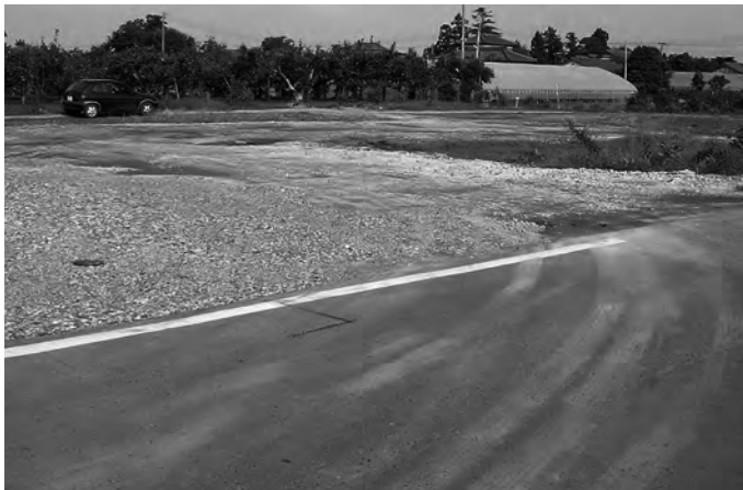
調査着手前（南西から）
