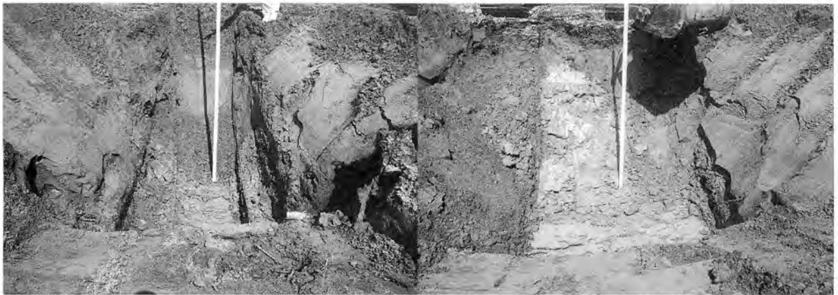
2 T 調査状況
