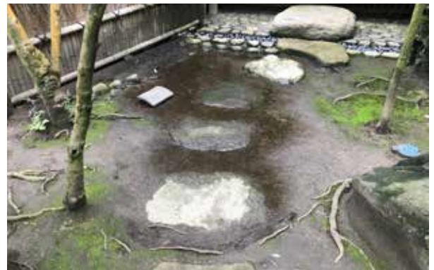
写真 3-77 主庭 排水不良
