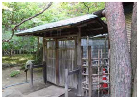
写真 3-58 庭門 北西から見る
