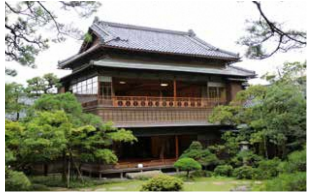
写真 3-32 主屋 座敷棟 北から望む
