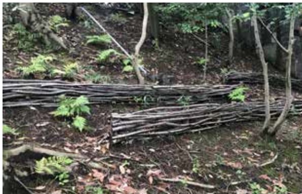
写真 3-76 主庭 裸地化斜面のしがら処置の様子
