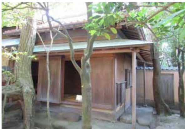
写真 3-46 茶室外観（内露地）
