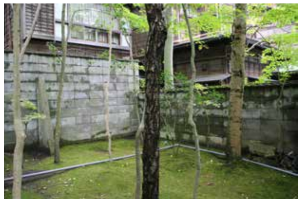
写真 3-61 敷地境界をなすブロック塀 南東隅部
