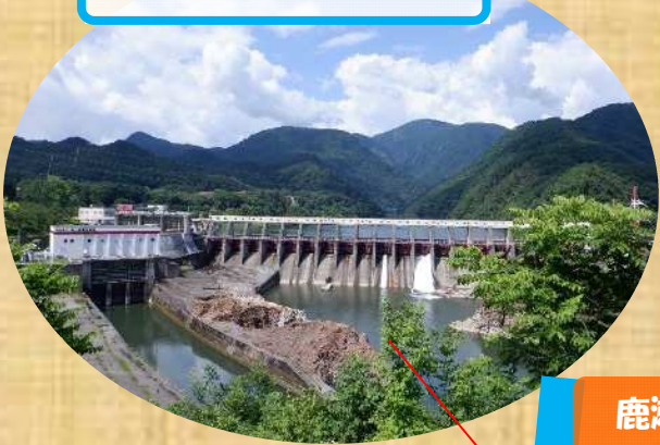
鹿瀬発電所（鹿瀬ダム）
