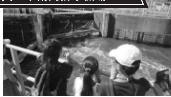
山の下閘門排水機場
