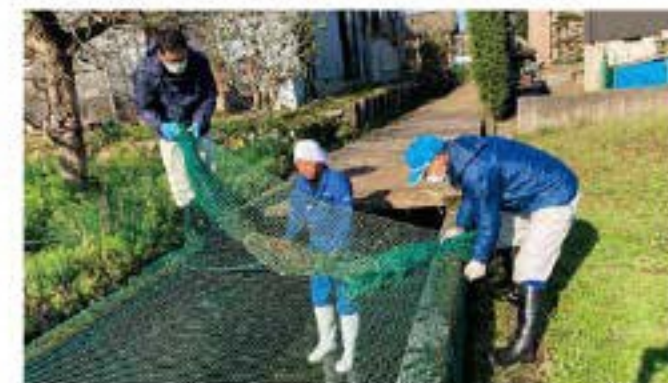
安全ネットの設置
