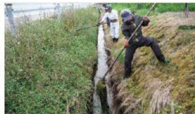
水路の瀬上げ
