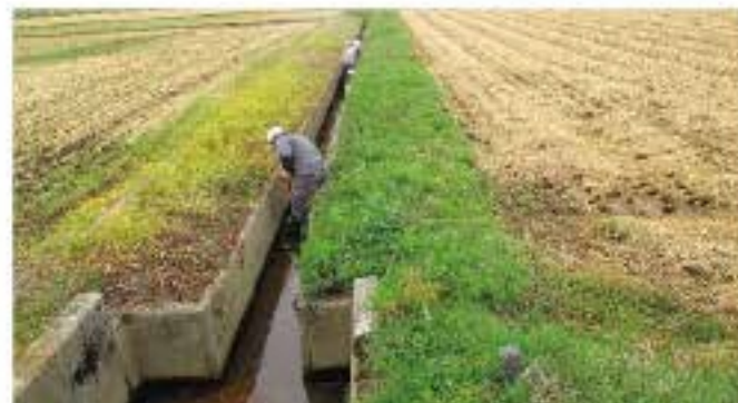
水路の泥上げ
