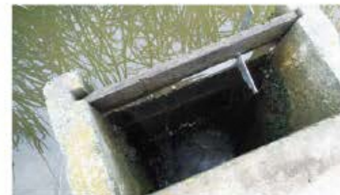
田んぼダム 調整金具の設置
