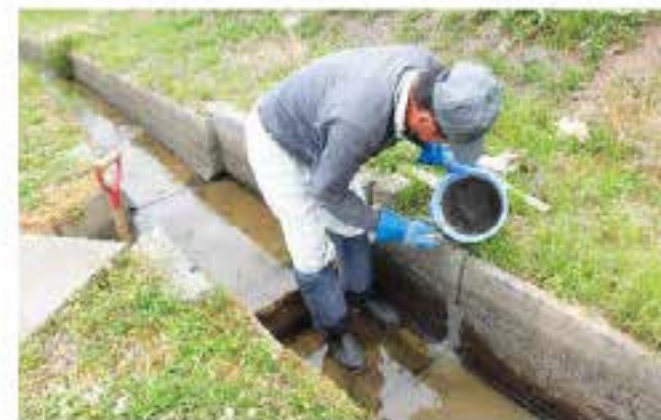
水路の目地詰め
