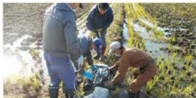
水路の軽微な補修等 （川口地区農地と環境を保全する会）
