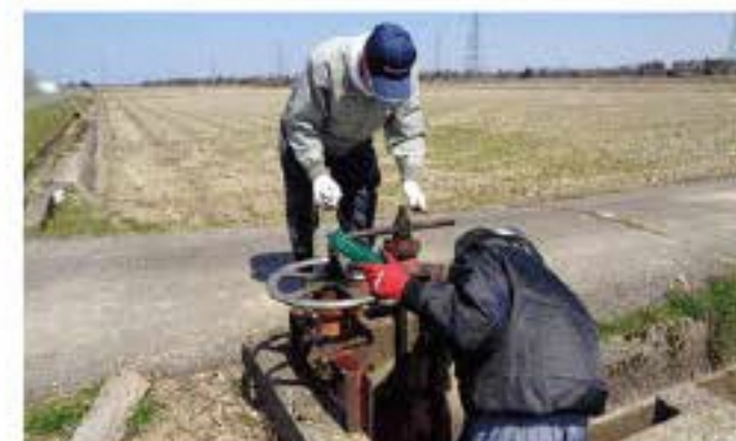
水路付帯施設の保守管理（新関保全会・大関）
