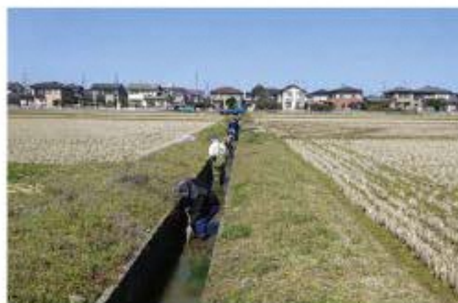
水路の泥上げ
