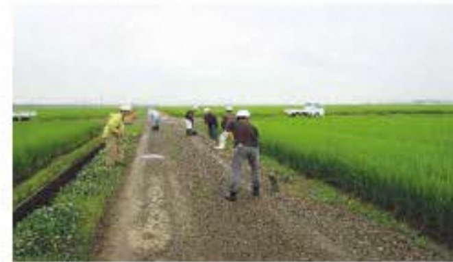
軽微な補修 (農道の路面維持)
