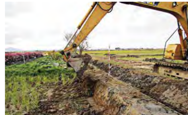
老朽化した排水路の改修工事
