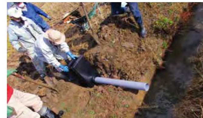
田んぼダム柵の設置作業
