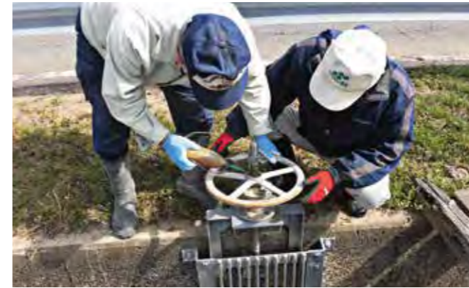
水路設備の点検とメンテナンス
