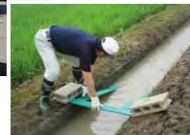
生き物スロープの作成・設置
