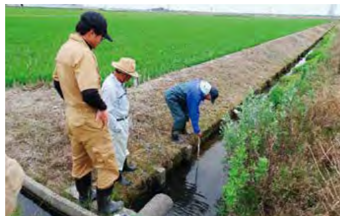
毎年欠かせない点検作業
