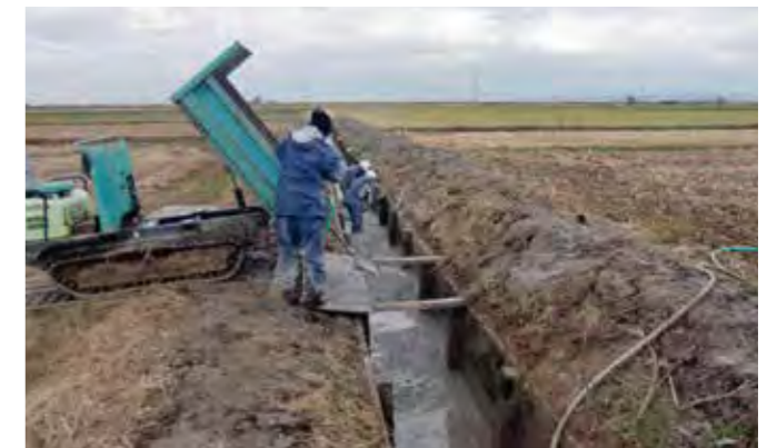
水路の軽微な補修等（野方・三ツ屋環境保全会）
