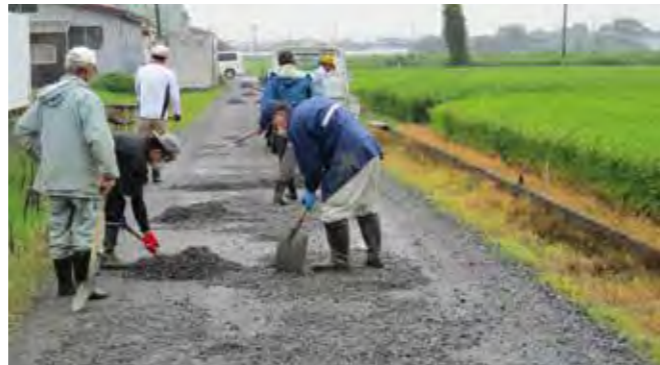
農道の砂利敷均し作業
