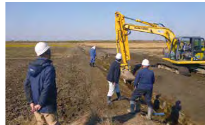
水路の軽微な補修等（矢代田第1グリーン環境保全会）
