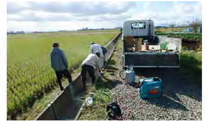
用水路の目地補修
