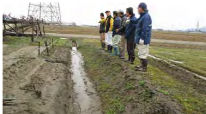
施設の点検・機能診断
