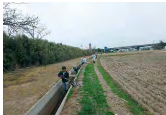
水路の泥上げ
