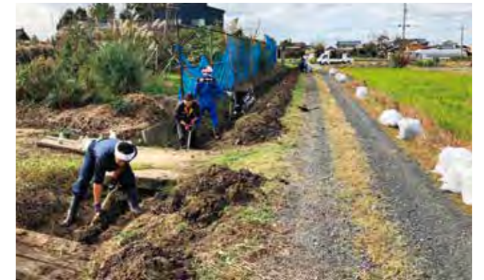
機械が使えない排水溝の手掘り作業
