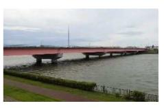
冬季の季節風を直に受ける過酷な作業環境下で、非出水期での完成が強いられるという厳しい状況の中、 無事に事故や苦情も無くしゅん工させた。梁下での作業は狭隘な空間での作業なため、ピックハンマーにア タッチメントを取付けたはつり機械を使用するなど工夫を凝らし、作業効率を向上させていた。新技術であ るコンクリート湿潤養生シートを採用し、補修部表面の緻密化を水和反応により促進させ、品質確保のため の工夫が凝らされていた。品質劣化を招かないよう、断面修復等の養生時は、吊り足場内をヒータ等で適切 な温度管理を行うなど、施工管理が徹底されていた。共生社会の推進を目指す「ともにEntrance」に賛同 し、現場周辺に障がい者が作画したアート看板やポスターを設置したほか、近傍の青山小学校に「ともにプ ロジェクト」の趣旨説明や啓発グッズを配付するなどし、関屋大橋や工事との一体でPRを行った。
