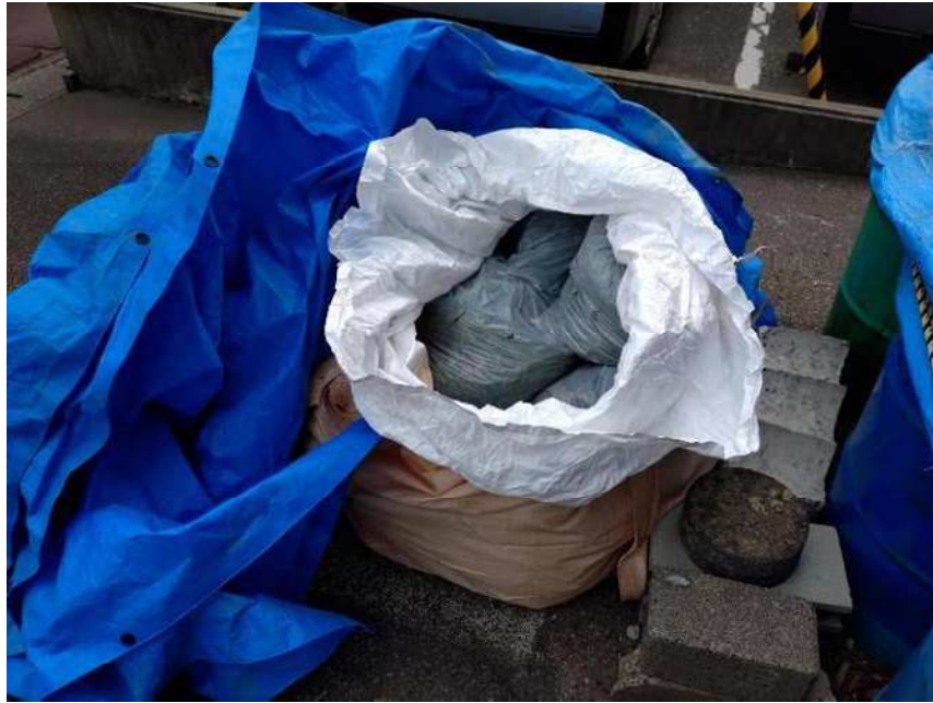
写真 5-1-3 伐採後に回収した植生 (ビニール袋に分取して詰め、フレキシブルコンテナバック に集積し、産業廃棄物として処分した)
