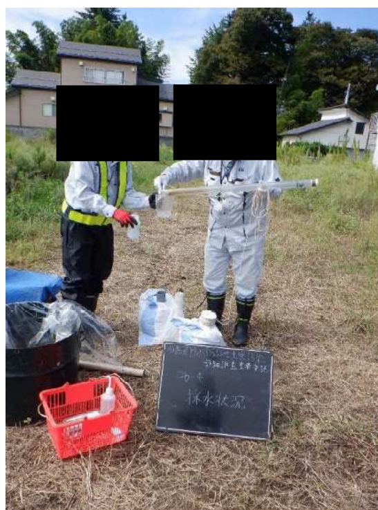
写真 5-3-2 地下水採取状況
