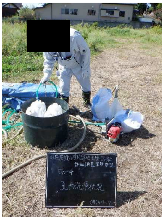
写真 5-3-1 孔内洗浄状況
