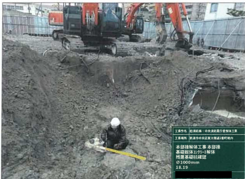
写真区分: 施工状況写真 写真タイトル: 本部棟解体工 事 本部棟 基礎躯体コンクリ ート解体 残置基礎杭確認 10 00mm 18.19
