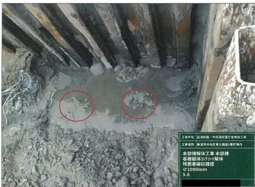
工事種名 旧消防局・中央消防署庁舎解体工事 工事場所 新潟市中央区茶臼山通1番町地内 本部棟解体工事 本部棟 基礎躯体コンクリート解体 残置基礎杭確認 φ1000mm 5.6
