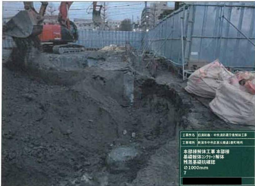
写真区分: 施工状況写真 写真タイトル: 本部棟解体工 事 本部棟 基礎躯体コンクリ ート解体 残置基礎杭確認 10 00mm 7
