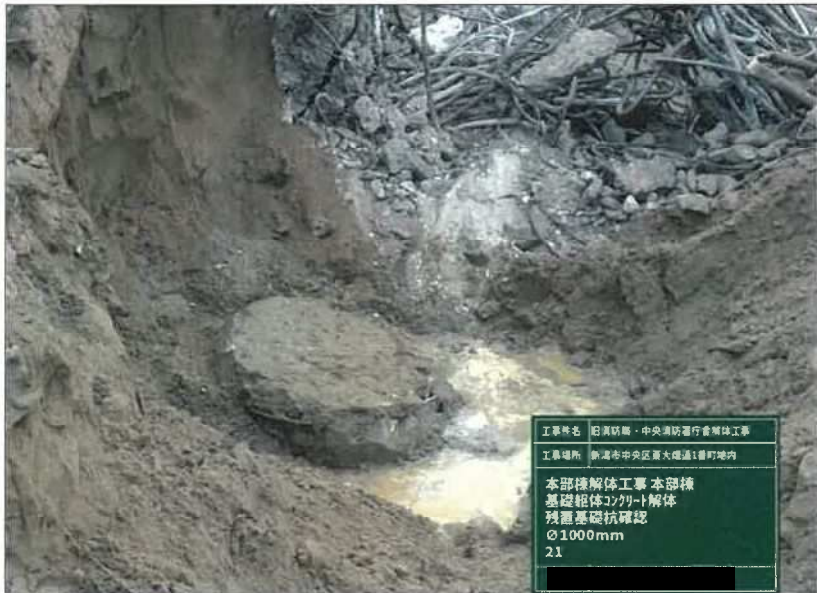
写真区分: 施工状況写真 写真タイトル: 本部棟解体工 事 本部棟 基礎躯体コンクリ ート解体 残置基礎杭確認 10 00mm 21
