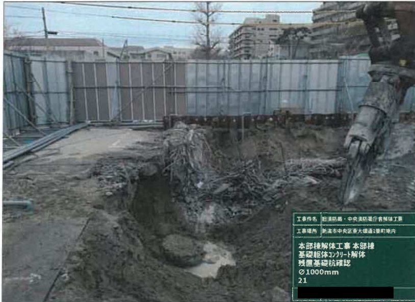
写真区分: 施工状況写真 写真タイトル: 本部棟解体工 事 本部棟 基礎躯体コンクリ ート解体 残置基礎杭確認 10 00mm 21
