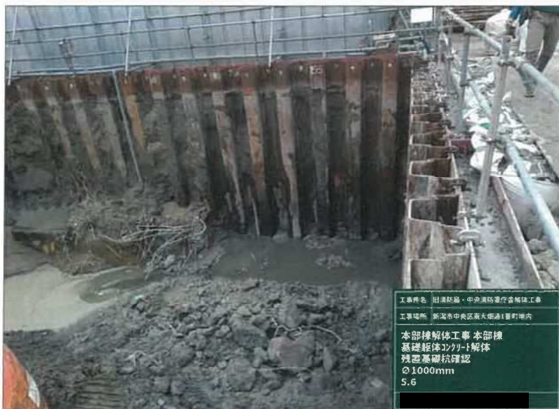
写真区分: 施工状況写真 写真タイトル: 本部棟解体工 事 本部棟 基礎躯体コンクリ ート解体 残置基礎杭確認 10 00mm 5.6
