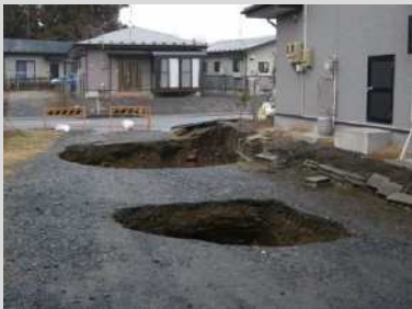
地盤の陥没
