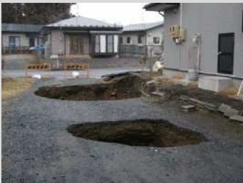
地盤の陥没
