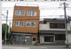
①住宅の沈下・傾斜
