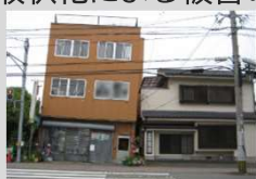
①住宅の沈下・傾斜
