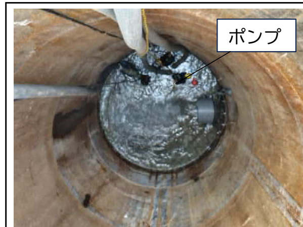
地下水位低下状況(立坑内)
