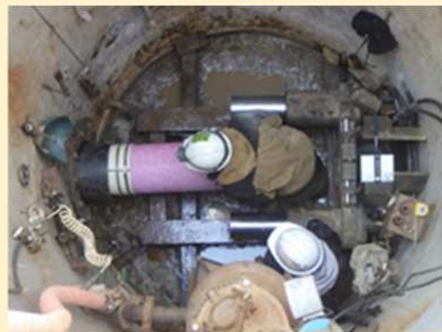
集水管設置のイメージ (推進工法)
