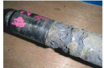
【ポンプ主軸の腐食】
