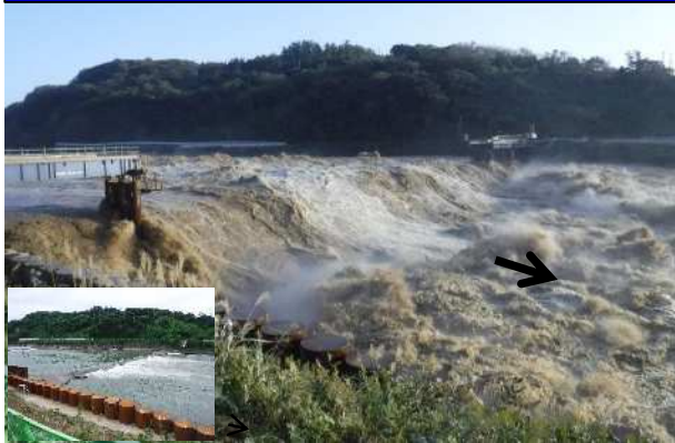
平常時 令和元年東日本台風時の 大河津分水路
