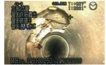
管の破損
