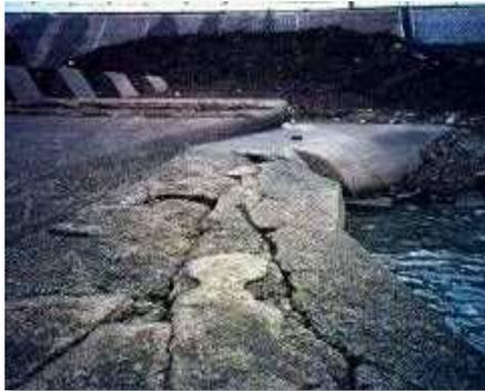
第二床固 水叩き部のひび割れ状況
