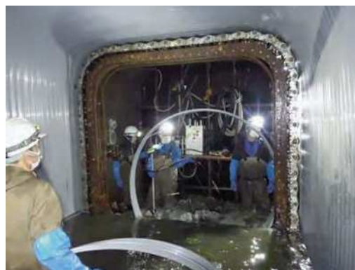
下水道管渠の改築工事
